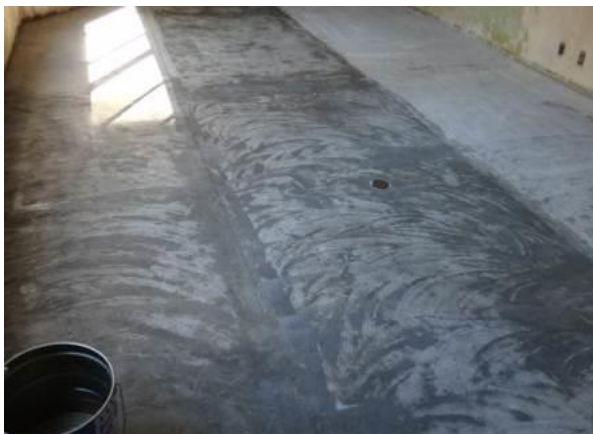
施工例 写真 1. タイルカーペット除去後の状況
