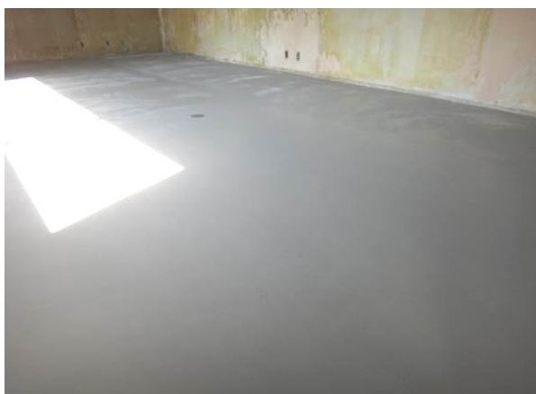
施工例 写真 2. NP カチオン施工後の状況
