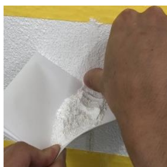
②ONE 粉体でひび割れを埋める。
