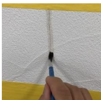
①筆でひび割れ箇所を水湿し。
