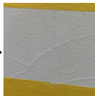
⑥補修完了。
