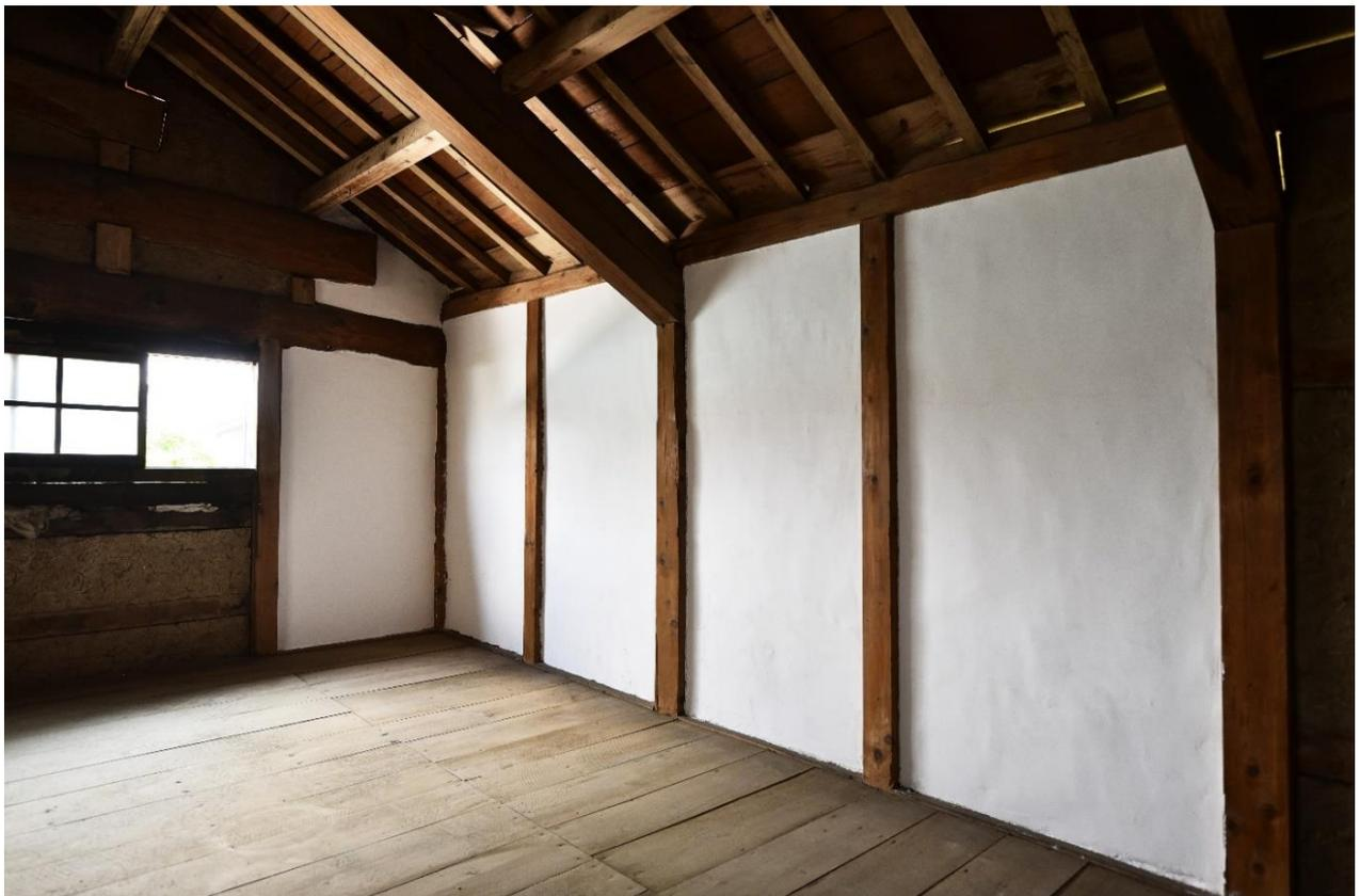
写真 13 土壁メンテ 中塗り漆喰を使用した土壁改修後の状況
