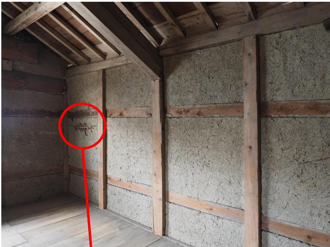
写真1 補修前の土壁下地の状況
