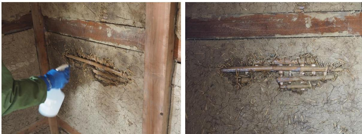
写真 5 竹小舞露出部分への塗布作業
