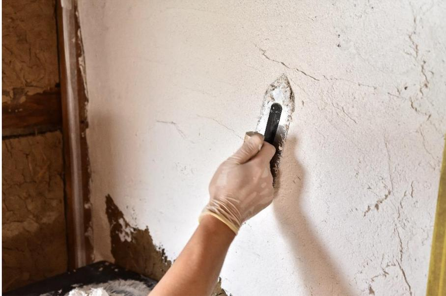
写真 9 土壁メンテ 中塗り漆喰による全面塗り作業
