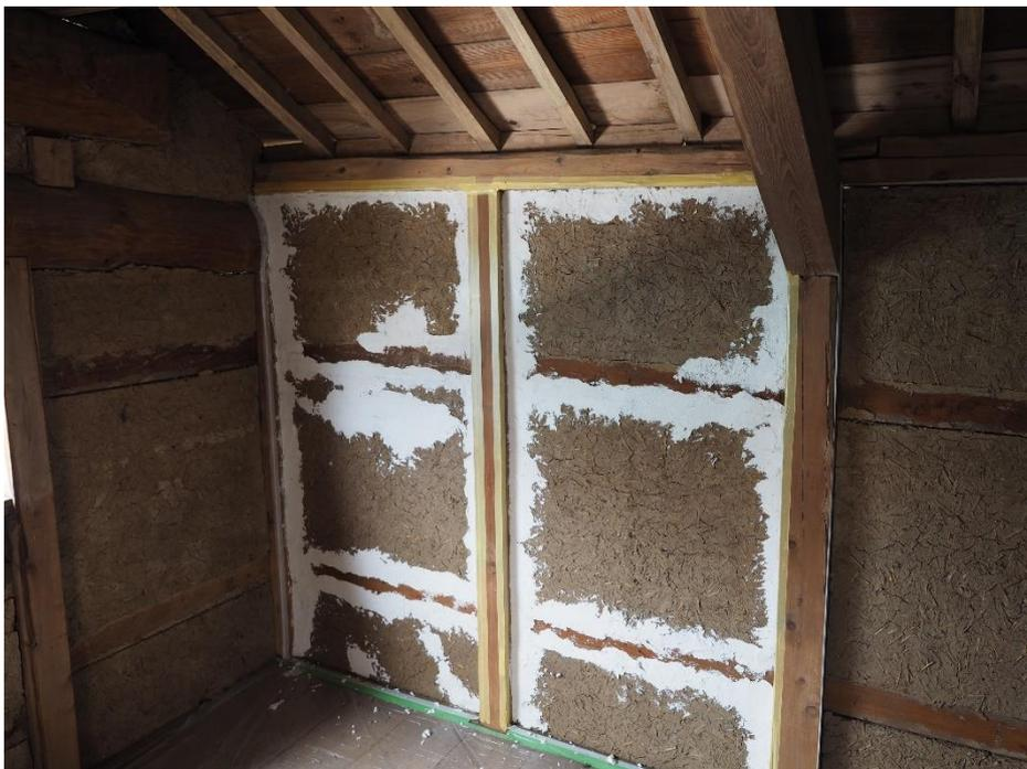
写真8 土壁メンテ 中塗り漆喰による欠損部・隙間補修後の状況
