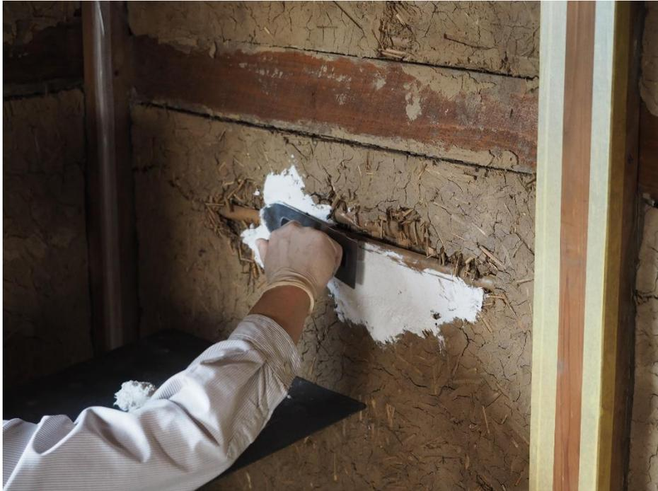
写真7 土壁メンテ 中塗り漆喰による欠損部補修作業
