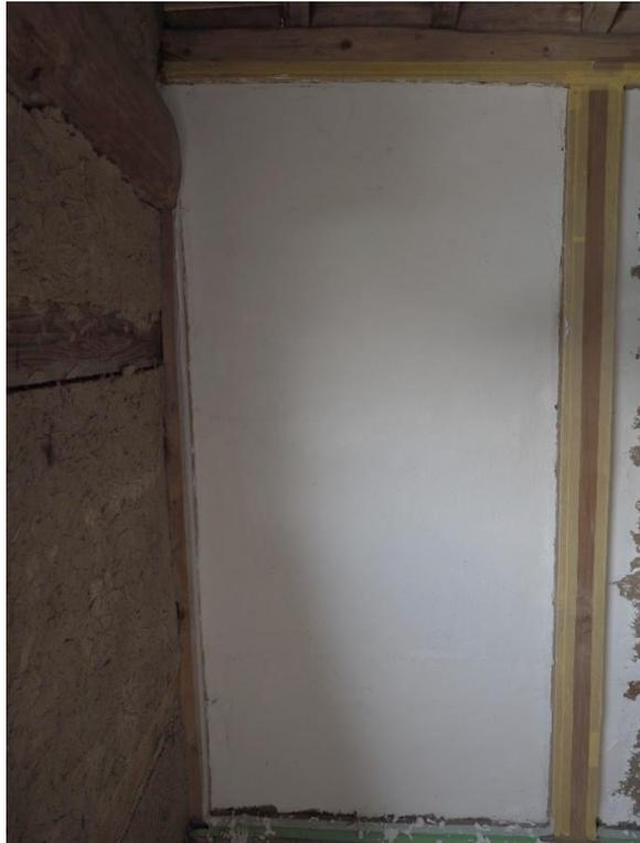
写真 12 土壁メンテ 中塗り漆喰による全面塗り後の状況
