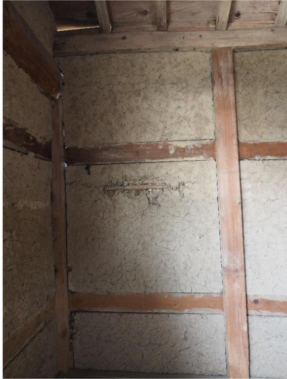
写真 11 土壁メンテ 中塗り漆喰 施工前の状況
