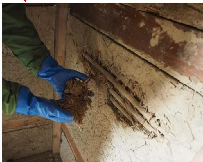
写真2 竹小舞が露出した劣化部分
