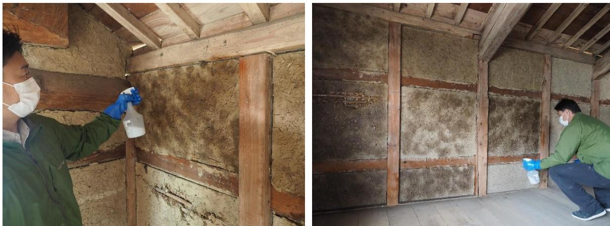
写真 3、4 浸透型表面強化剤の噴霧器による塗布作業
