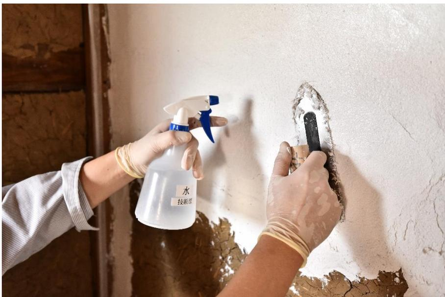
写真 10 霧吹き噴霧による表面押さえ作業
